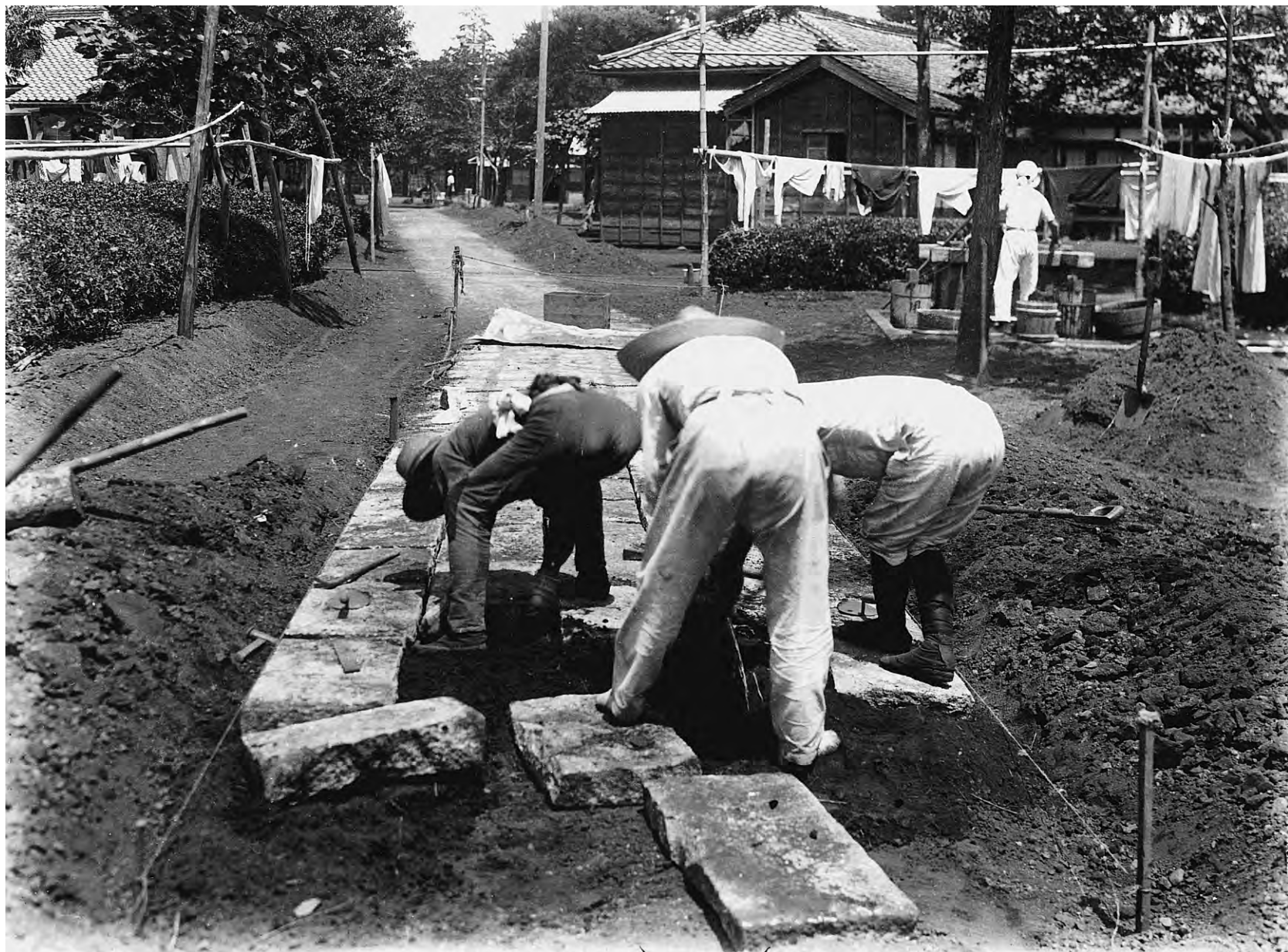
敷石敷設作業
